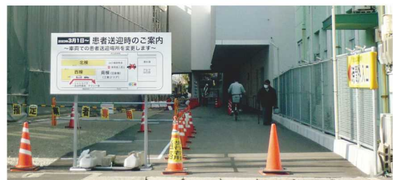
▲西棟-北棟間入口
