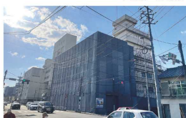
▲解体工事の様子(旧東棟)
