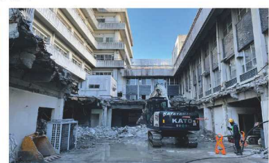
▲解体工事の様子(旧整形外科)
